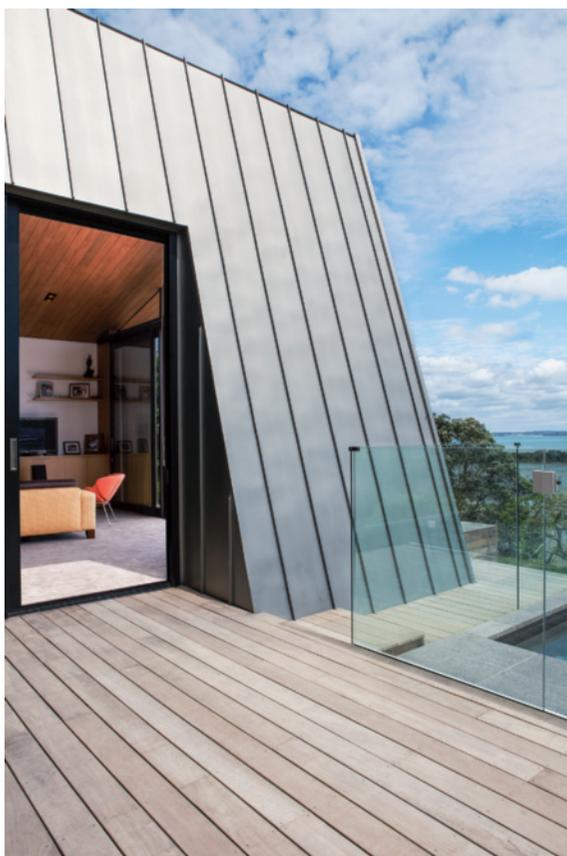
La nuova porzione dell'edificio è rivestita da pannelli in zinco, che evidenziano il contrasto con la struttura preesistente
